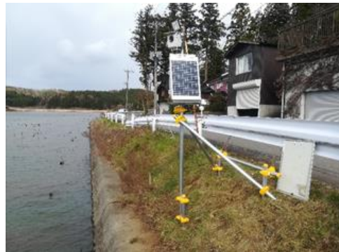
カメラ設置状況
