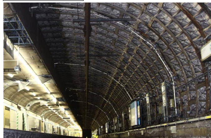
断面への取り付け状況
